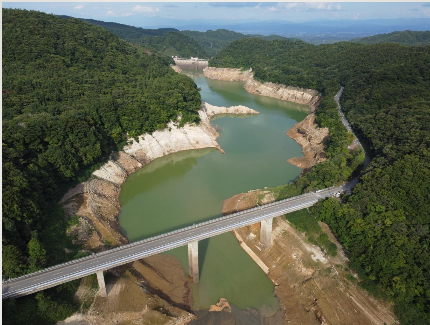
夏油大橋 橋梁補修
