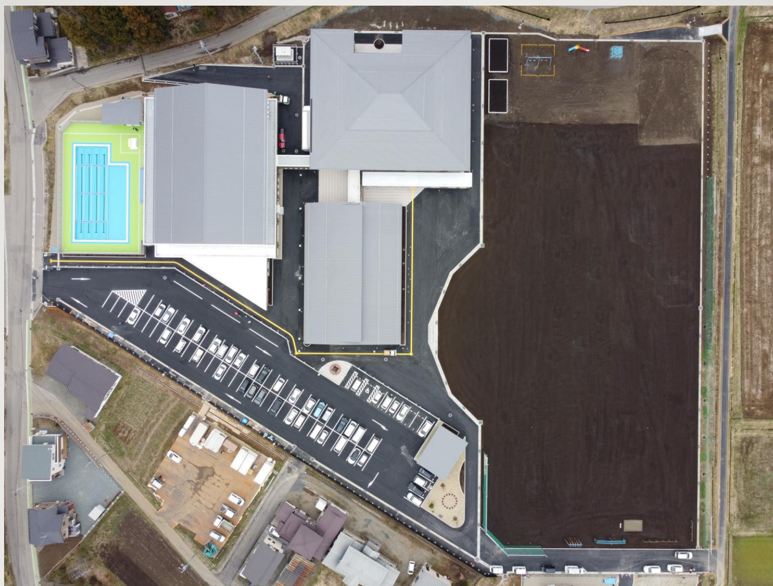
北上市立東桜小学校（グラウンド工事）
