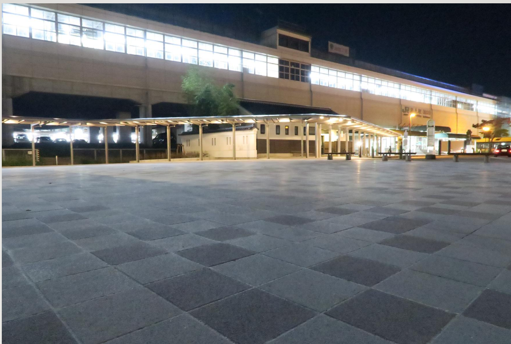
北上駅東口整備
