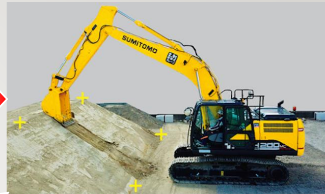
コンピューターがサポートして掘る
