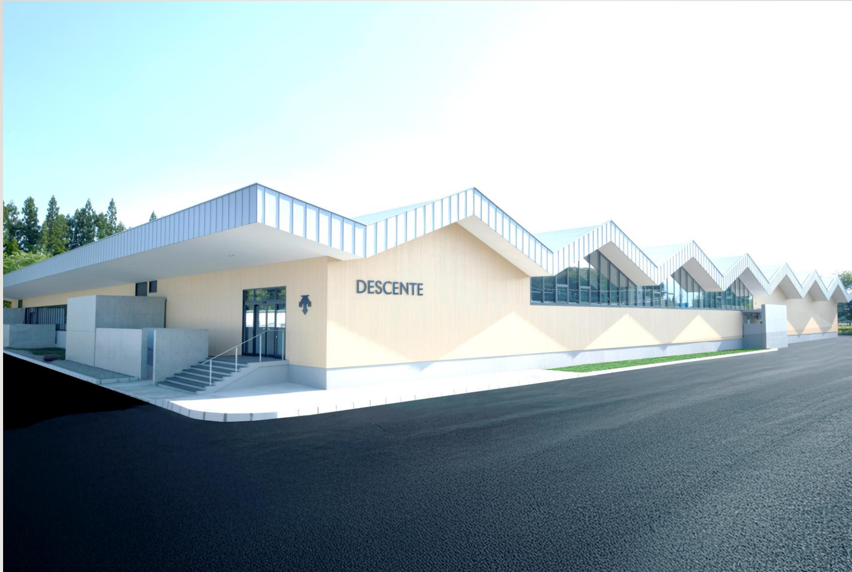
スポーツウェア製造工場（奥州市）
