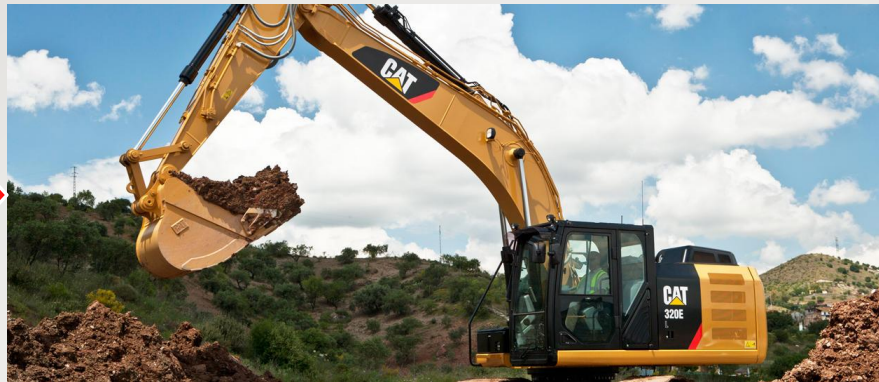
機械（重機）で掘る
